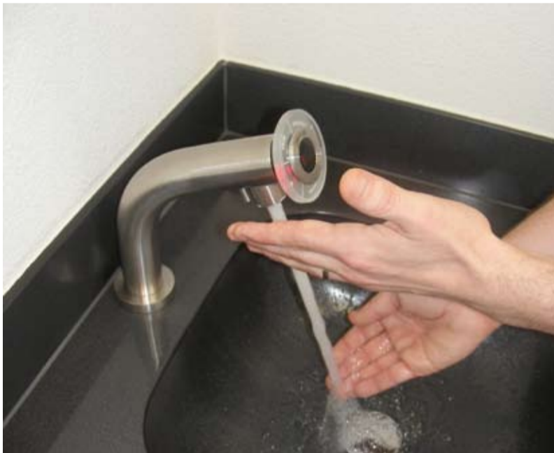
Lichtsensoren erfüllen den Wunsch nach Wasser samt der richtigen Temperatur von kalt bis heiss, nach Seife und nach Desinfektionsmittel, ohne dass ein Hautkontakt nötig ist
